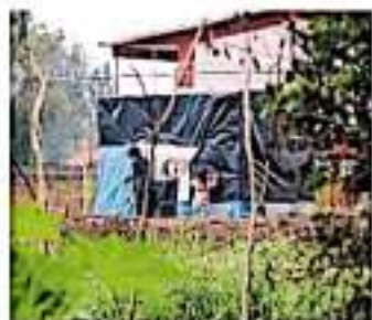
Se acumulan 14 casas irregulares / FERNANDO VELÁZQUEZ
