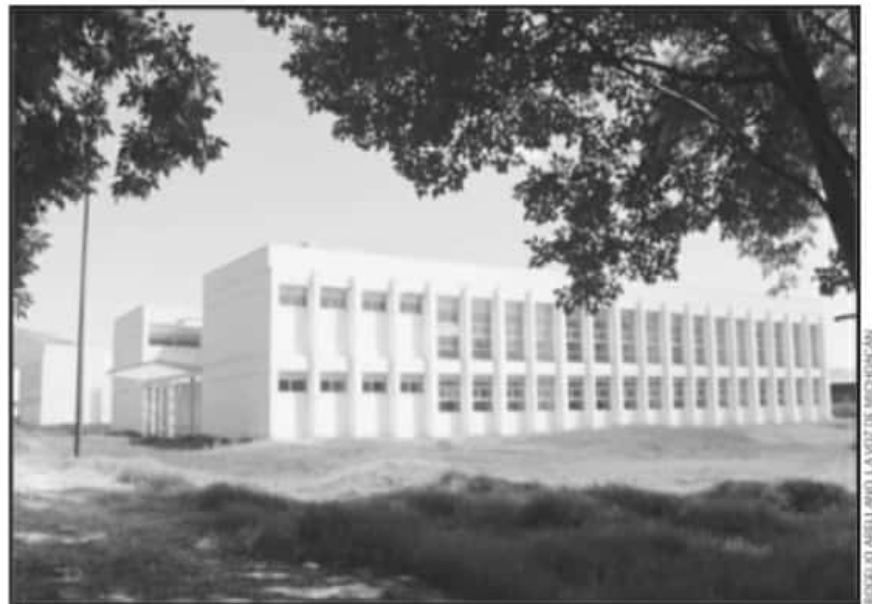
EN BREVE, SE CULMINARÁN LOS TRABAJOS DEL NUEVO CAMPUS-URUAPAN, DE LA UMSNH. UNA OBRA ANHELADA.
