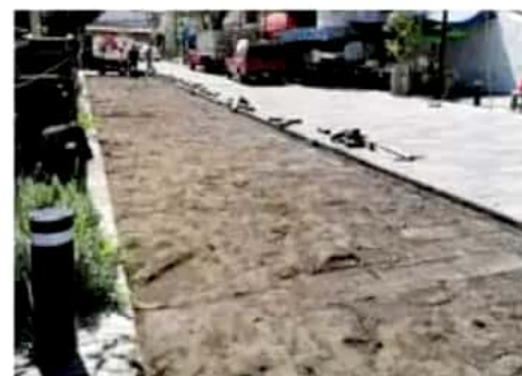
Reparación. Tras el daño causado a la loseta de adoquín, éste fue sustituido por concreto. /CORTESÍA
