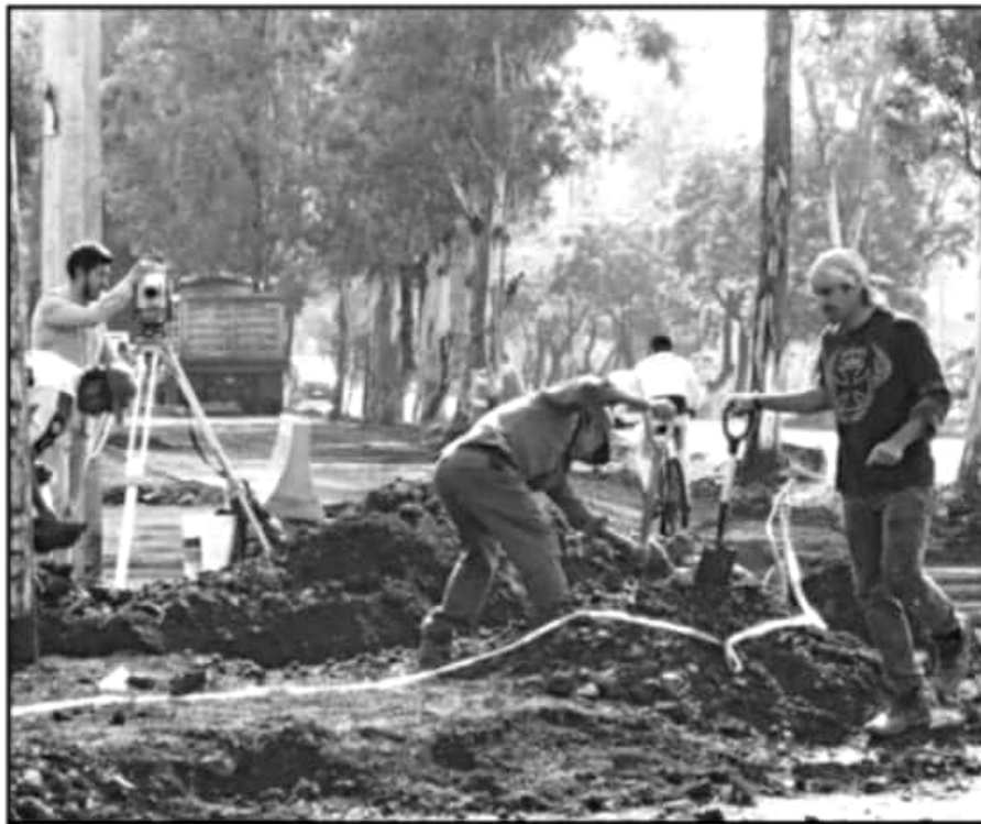
APURAN LAS OBRAS EN LA LATERAL DE LA AVENIDA MADERO PONIENTE Y PROMETEN ACABARLA EL 15 DE OCTUBRE.
