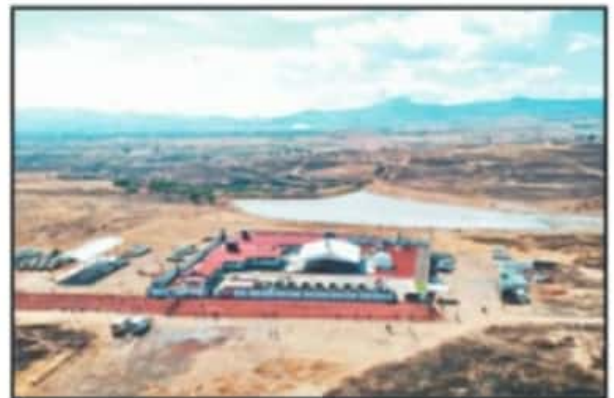
ASÍ ES COMO SE VEN LAS INSTALACIONES DEL CUARTEL DE MARAVATÍ.
