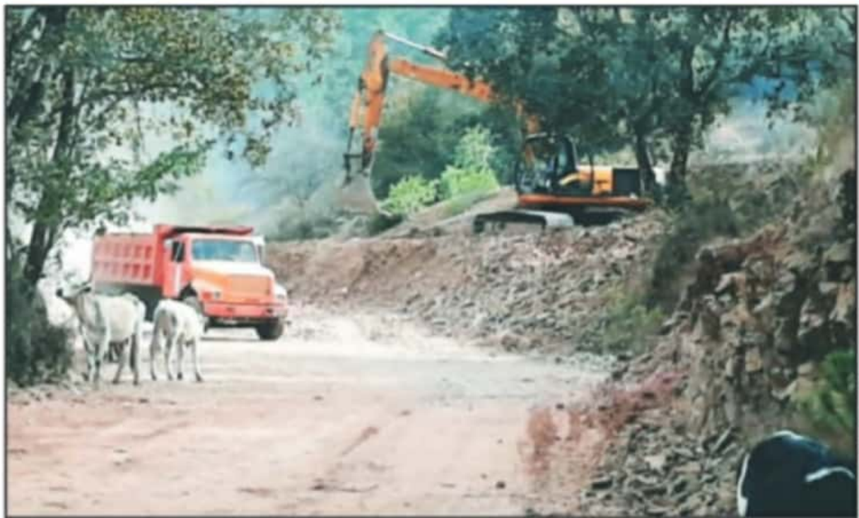
SE ESPERA QUE EN LAS PRÓXIMAS HORAS LAS AUTORIDADES MUNICIPALES ACUDAN A PONER SELLOS DE CLAUSURA A LA MAQUINARIA QUE HACE LAS OBRAS.
