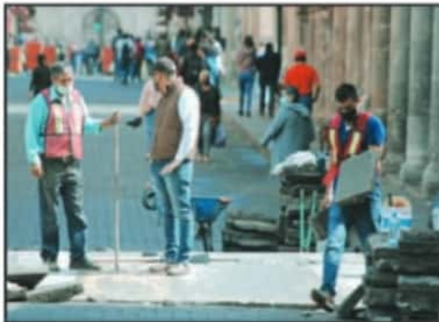
CONTINUAN LAS OBRAS EN EL CUADRO PRINCIPAL DE LA CIUDAD DE MORELIA, LAS CUALES SE LLEVAN INTENTANDO SEGUIR LAS MEDIDAS SANITARIAS.
