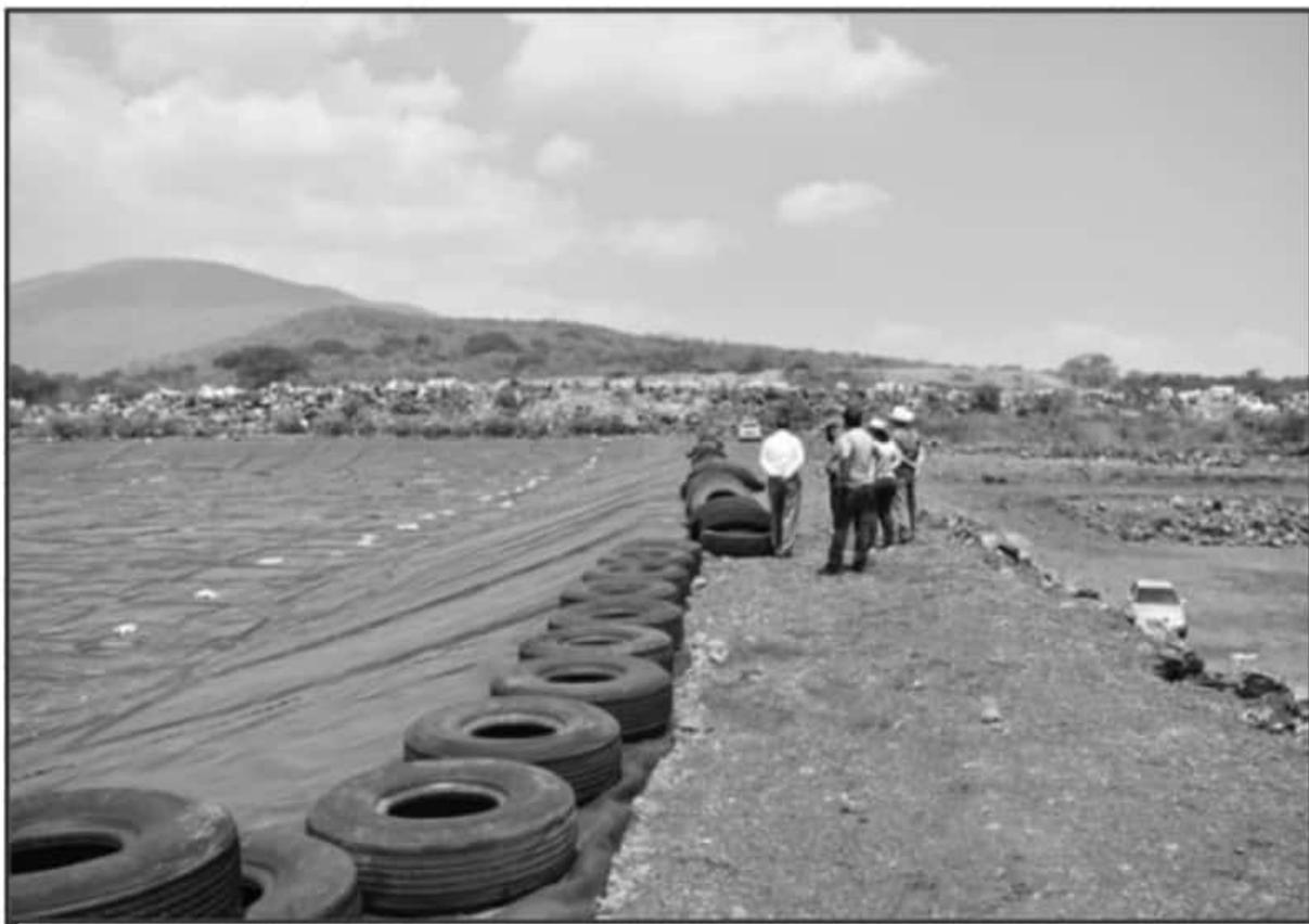
EL RELLENO SANITARIO TIENE UNA SALIDA A OTRA FOSA CON RECUBIERTO DE HULE, CON LA INTENCIÓN DE DRENAR LOS LÍQUIDOS Y MEJORAR SU CICLO.
