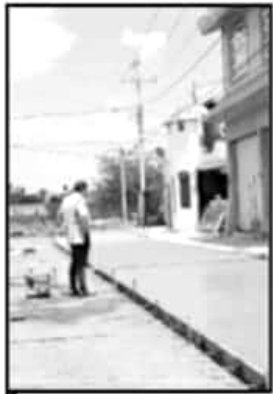
EL COLADO DE CONCRETO ESTARÁ ESTE FIN DE SEMANA; PREVEN EN- TREGAR LA CALLE EN 20 DÍAS MÁS.
