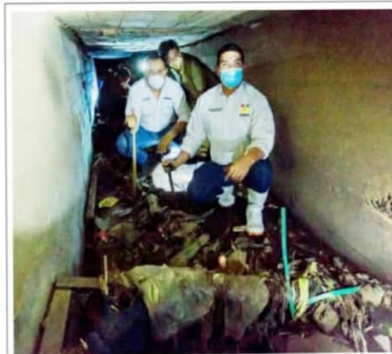
URUAPAN, MICH.- El alcalde, Miguel Ángel Paredes Melgoza, recorrió la tarde de este jueves la bóveda para drenajes ubicada en la Calzada Benito Juárez, entre Avenida Chispas y Michoacán, acompañado del director de la Capasu, Luis Manuel Magaña Magaña para constatar la situación de la bóveda y el azolve que registra, invitando a los uruapaneses a ser tanto conscientes como responsables, evitando tirar basura en las calles para evitar el taponamiento de alcantarillas y bóvedas.
