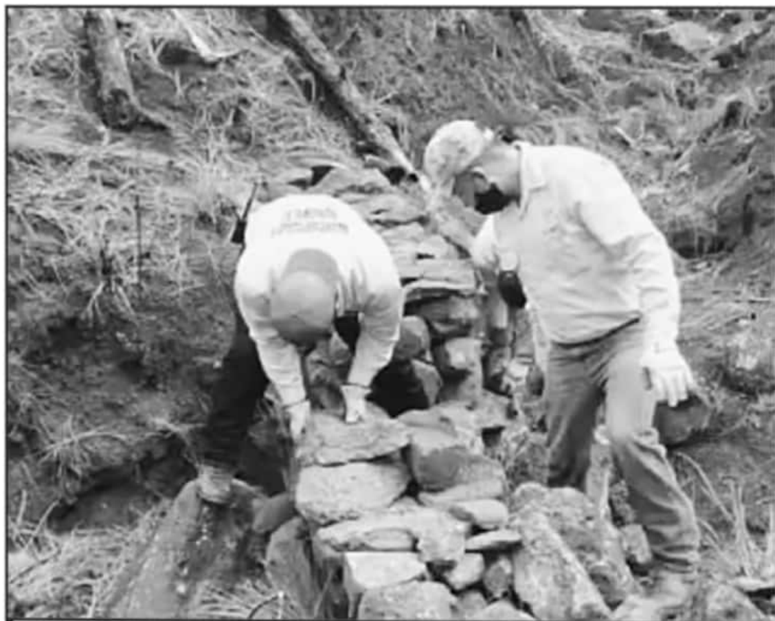
ANTE LA TEMPORADA DE LLUVIAS, CONSTRUYEN REPRESAS PARA EVITAR DESLAVES. YA HA PASADO EN AÑOS ANTERIORES, POR LO QUE AHORA PREVIENEN.
