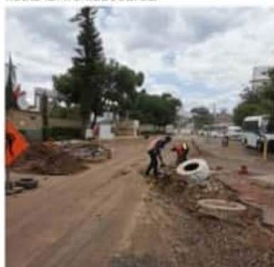
ZAMORA, MICH.- Se aplicaron las capas de filtro, sub-base y base, además de la compactación del terreno y la sustitución de la línea de drenaje de la zona, para brindar servicios eficientes a los vecinos.
