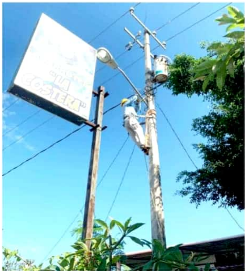
CD. LÁZARO CÁRDENAS, MICH.- Los trabajos de sustitución de lámparas de vapor de sodio por tecnología LED, que impulsa el gobierno municipal de Lázaro Cárdenas, presentan importantes avances.
