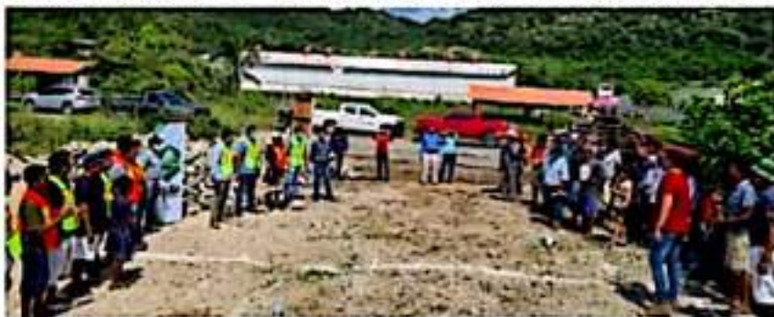
El alcalde de Aquila, José María Valencia arrancó las obras de construcción de la Casa del Pescador, en Maruata.
