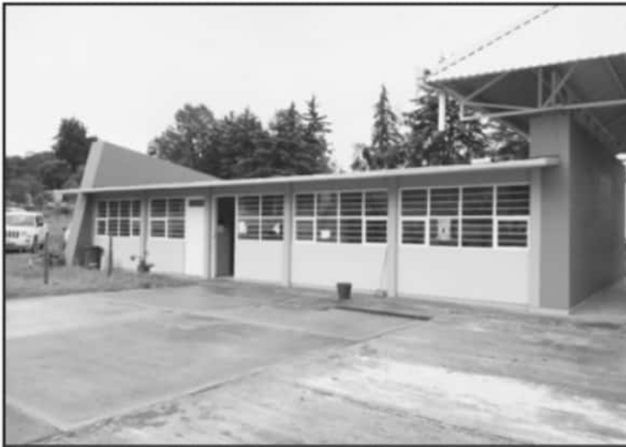
TRABAJARON DESDE AULAS, PASANDO POR TECHUMBRES Y HASTA INSTALACIONES PARA LOS BAÑOS.
