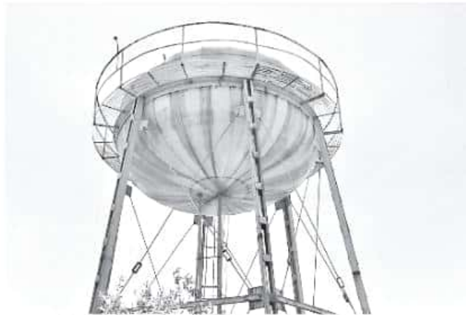
Subdirección de Distribución de Agua Potable dijo que la estructura no se encuentra en condiciones óptimas para su restauración. MARIANA LUNA
