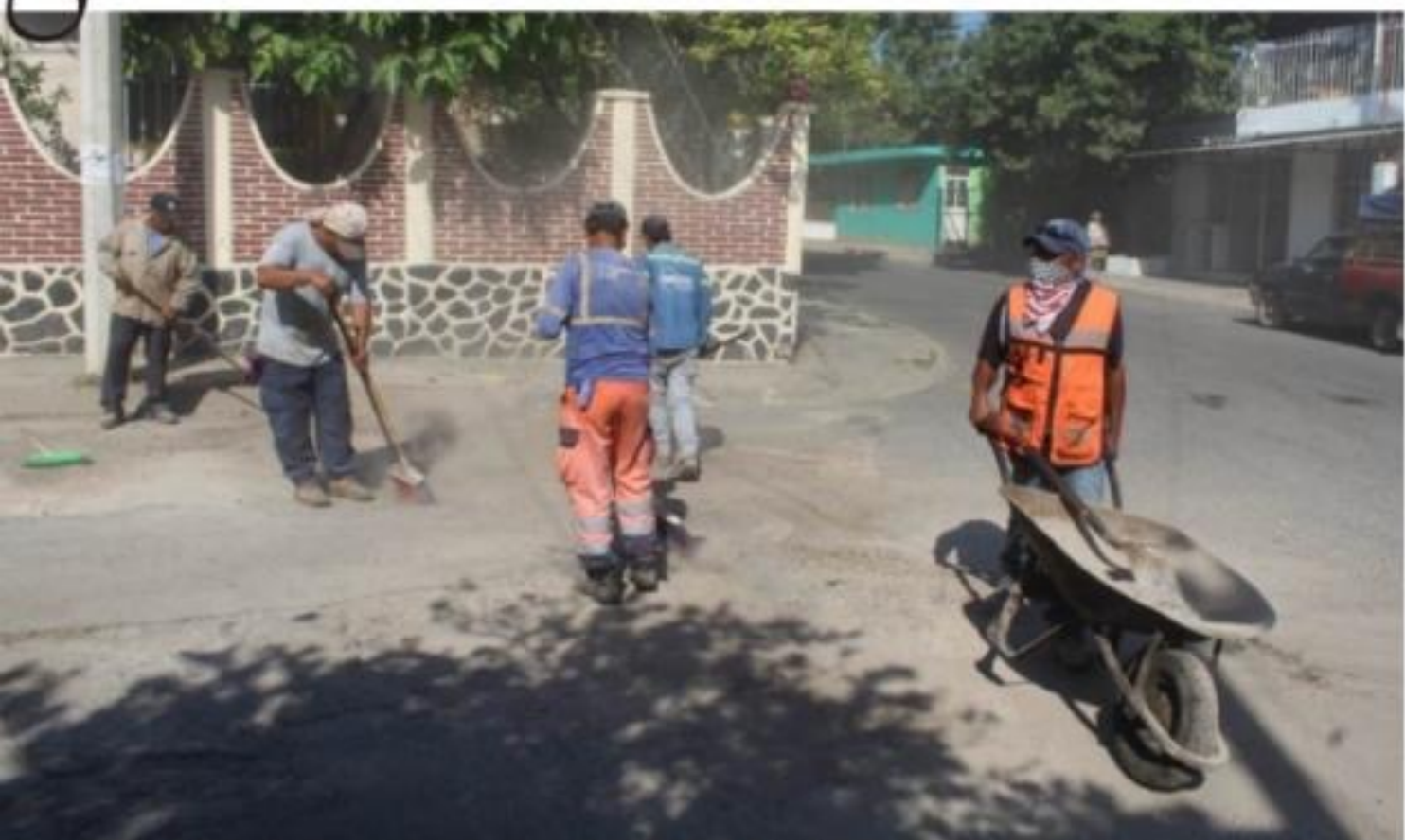
CD. LÁZARO CÁRDENAS, MICH.-La Secretaría de Obras Públicas, ha dado continuidad a los trabajos de mantenimiento en 700 metros lineales de la Avenida Tariácuri y en la calle Justo Sierra.
