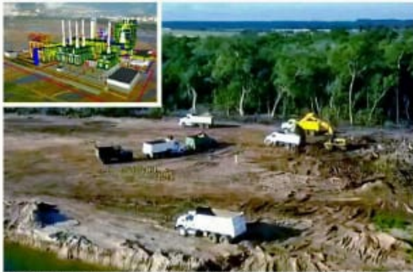
El Gobierno federal declaró ayer iniciados los trabajos de acondicionamiento de terrenos donde se construirá la refinería de Dos Bocas; arriba, la proyección de la obra terminada.
