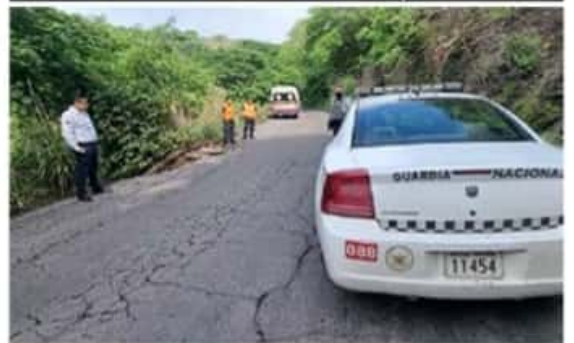
El corte de la carretera es en el tramo Lombardía-Santa Castida, por lo que la carretera libre Cuatro Caminos-Uruapan, no tienen ningún problema para el tránsito vehicular, señalar la GN.
