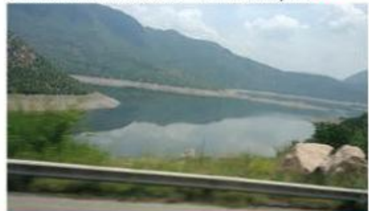
En la actualidad la presa Infiernillo presenta uno de sus niveles más bajo por la falta de lluvias no solo en Michoacán sino en varias entidades del país por donde atraviesa el río Balsas que la alimenta.
