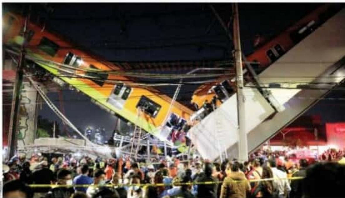
LOS VAGONES DEL METRO que cayeron anoche al colapsar la estructura de la llamada Línea Olivos, que pasa encima de la avenida Tláhuac.
