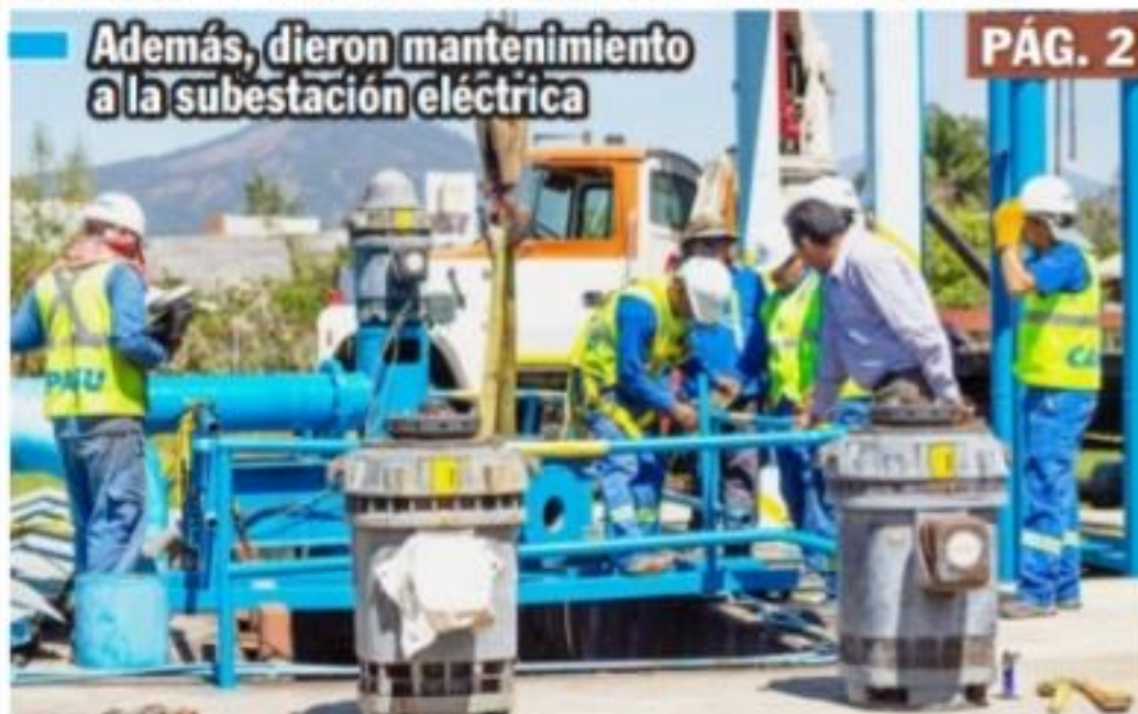
URUAPAN, MICH.- La Capasu realizó ayer labores de mantenimiento a la planta de tratamiento de aguas residuales Santa Bárbara.
