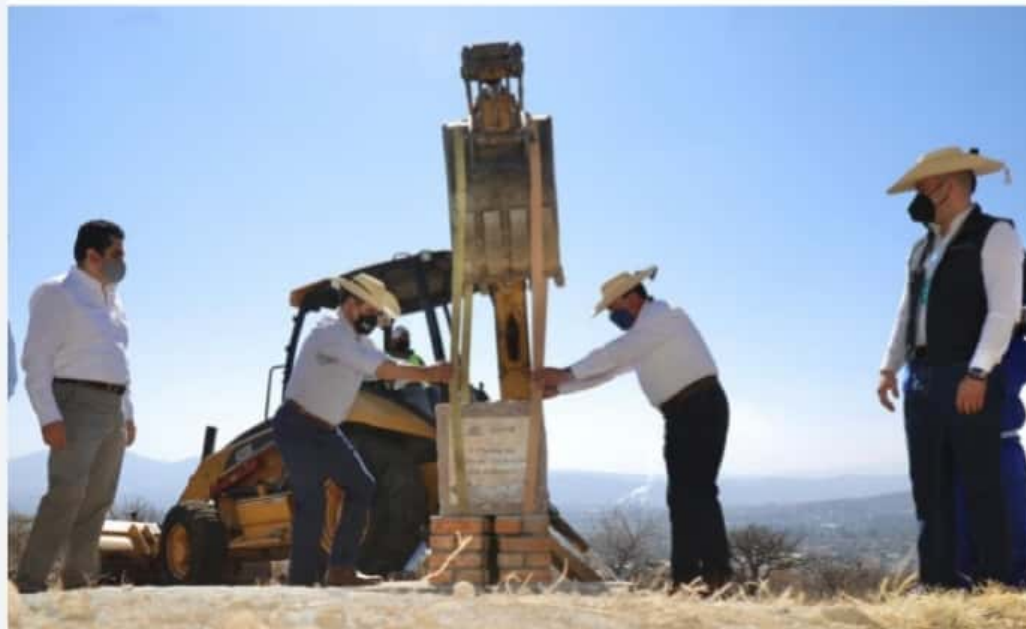
MORELIA, MICH.- El gobernador del estado, Silvano Aureoles Conejo, encabezó la colocación de la primera piedra de las oficinas centrales del Cobaem.
