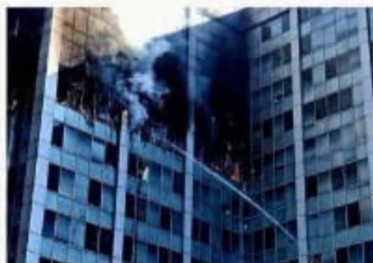
Un corto circuito causó el incendio, según el peritaje.
