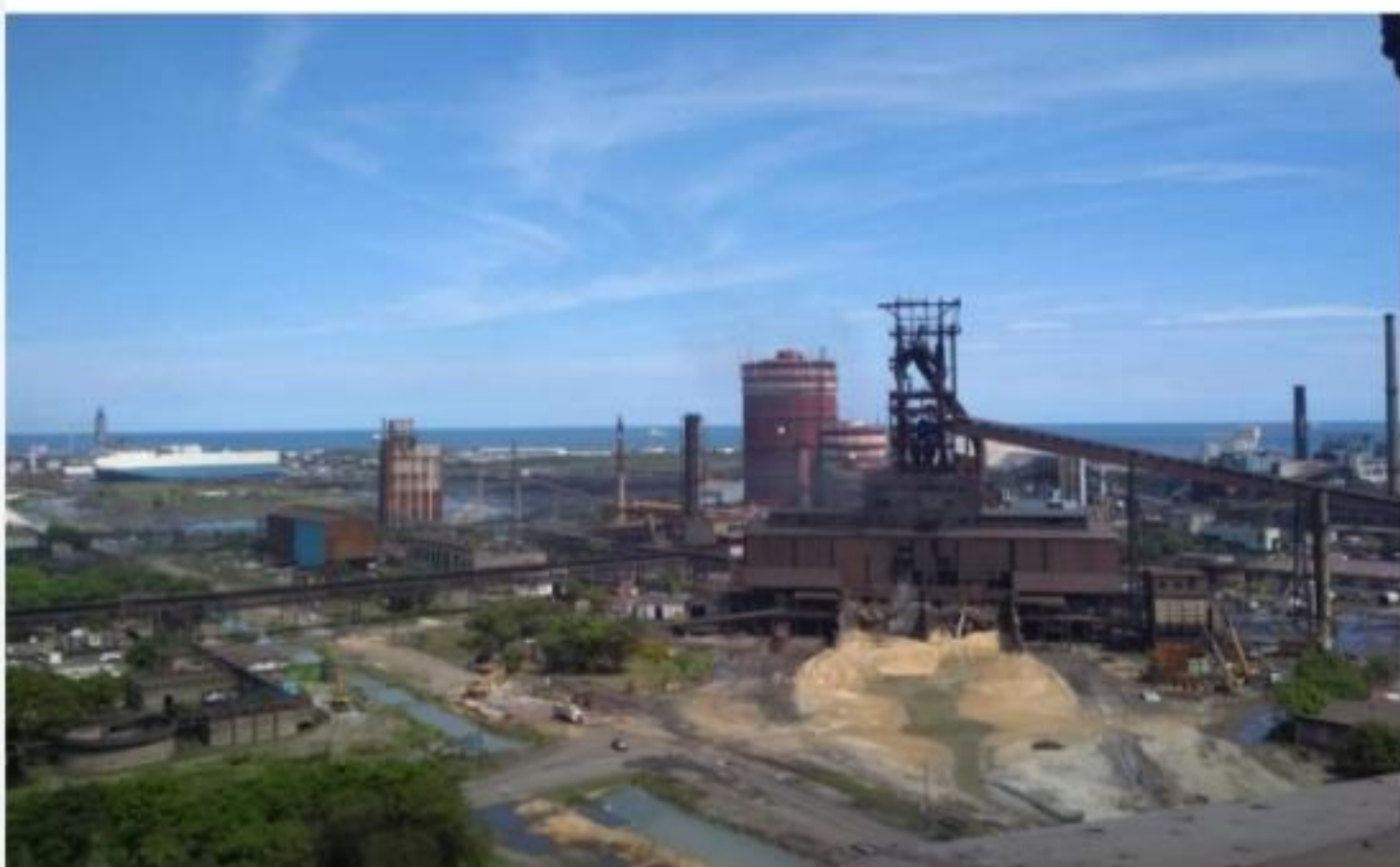
CD. LÁZARO CÁRDENAS, MICH.- El Sindicato Minero detuvo la construcción del nuevo laminador de rolado caliente.
