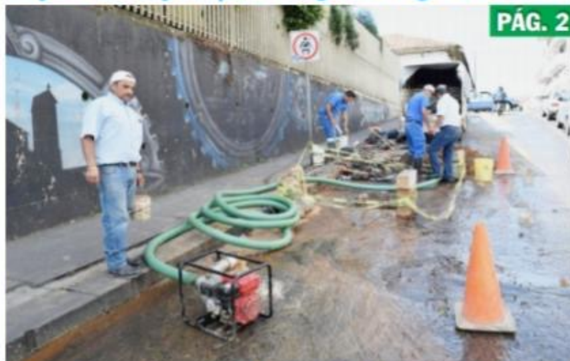
URUAPANM, MICH.-Trabajadores de la Capasu en plena faena en calles del centro de la ciudad.
