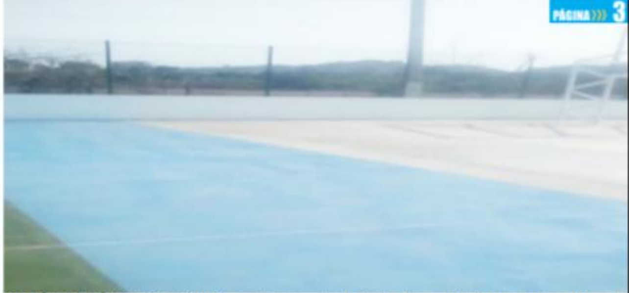
CD. LAZARO CÁRDENAS, MICH.- Se continúa con los trabajos de ampliación y construcción en la Unidad Deportiva de La Mira, presentando actualmente un avance del 90 por ciento en su ejecución.
