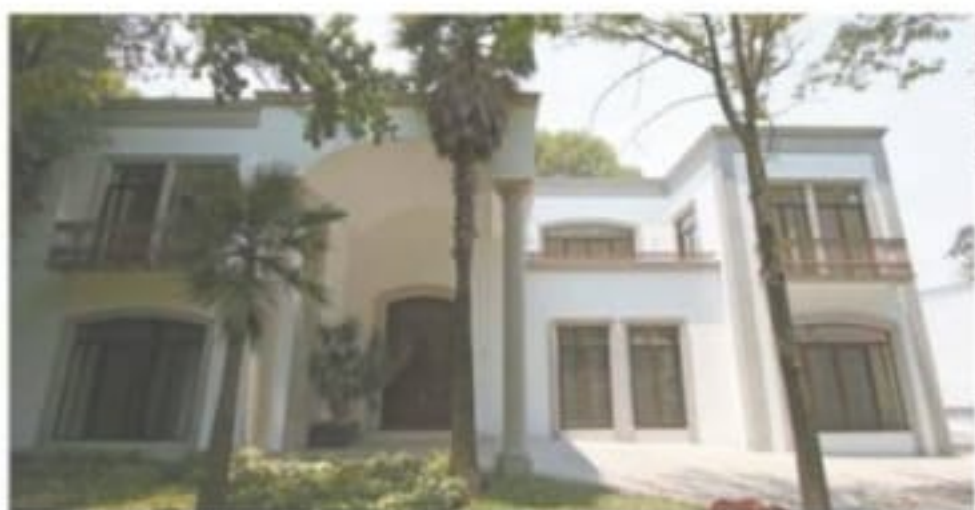
Fachada de la casa de oficinas de la entonces primera dama Angélica Rivera en Los Pinos, la cual fue edificada sobre una de las cabañas que Vicente Fox había construido y en la que vivían sus hijos.
