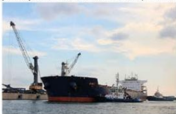
La central carboeléctrica de Petacalco, inició operación para la importación de carbón mineral, a través de la Terminal Portuaria del Pacífico. Además seguirá haciéndolo en la de Carbonser.
