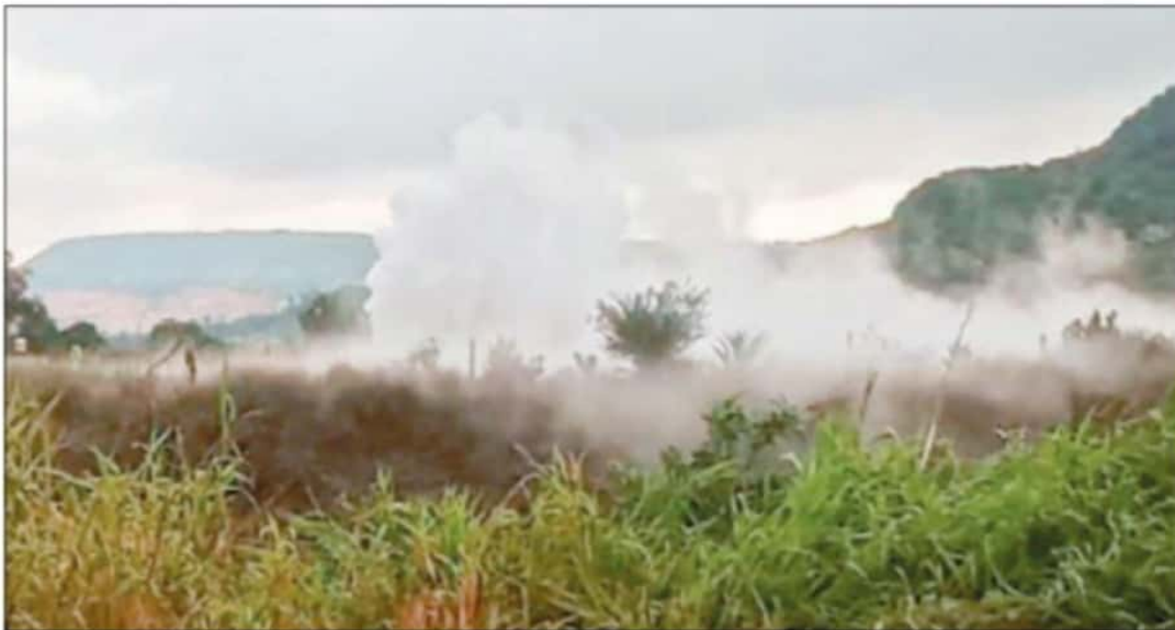
▲ La fuga en un ducto de gas LP de Pemex en la localidad Santa Ana Azcapotzaltongo, municipio de Tepeji del Río, Hidalgo, fue controlada al
