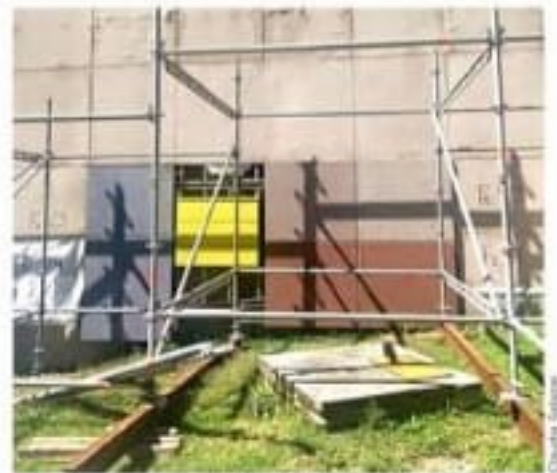
El material retirado de San Lázaro muestra los daños que sufrió con la lluvia. Servirá como parte de las pruebas en el juicio.
