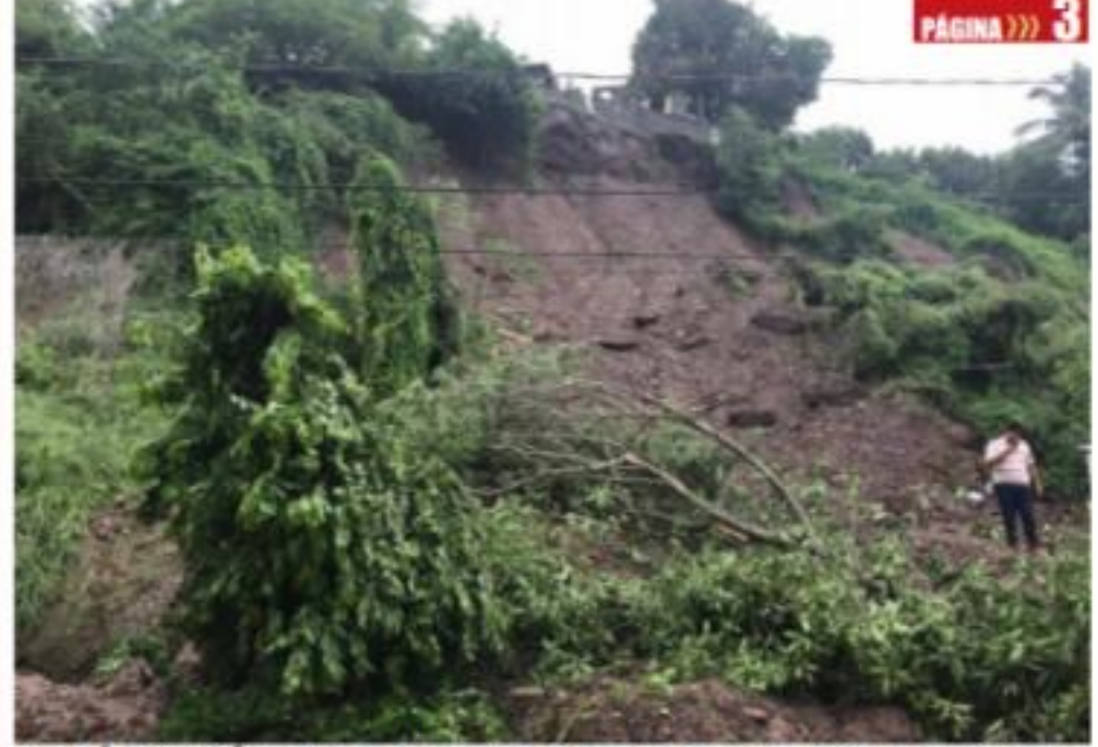
CD. LÁZARO CÁRDENAS, MICH.- Abel Toledo Serrano, jefe de tenencia de Las Guacamayas dijo que ya se hizo la declaratoria de Protección Civil de que el Cerrito de Guacamayas es zona de alto riesgo, por lo cual las familias que viven en la parte superior y en la parte baja deben ser reubicados ante otro posible deslave.
