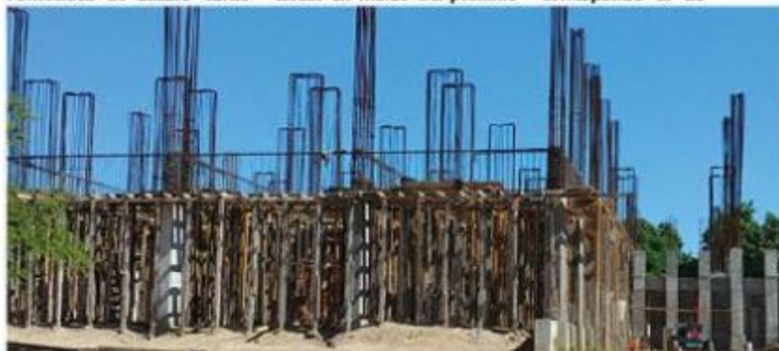
El edificio de la Biblioteca y Centro de Información, es el edificio que más avance físico lleva, de lo que serán las instalaciones de la Universidad Politécnica de Lázaro Cárdenas, ubicadas en las inmediaciones del Cecytem 05.
