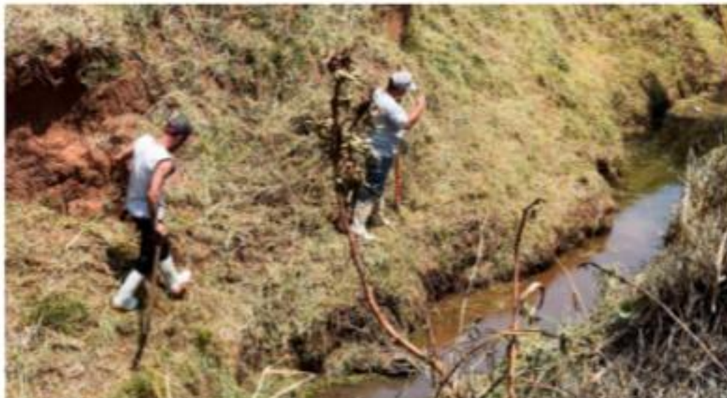
TANGANCÍCUARO, MICH.- En tiempo y forma iniciaron los trabajos de desazolve y limpieza de canales y arroyos para prevenir riesgos de inundaciones en la próxima temporada de lluvias.
