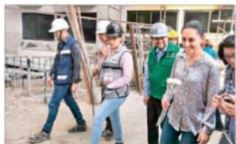
DOS AÑOS. Claudia Sheinbaum, jefa de Gobierno capitalina, informó que en 832 predios no será posible reconstruir las viviendas, debido a la presencia de grietas, tras el sismo del 19-S. CDMX P.9
