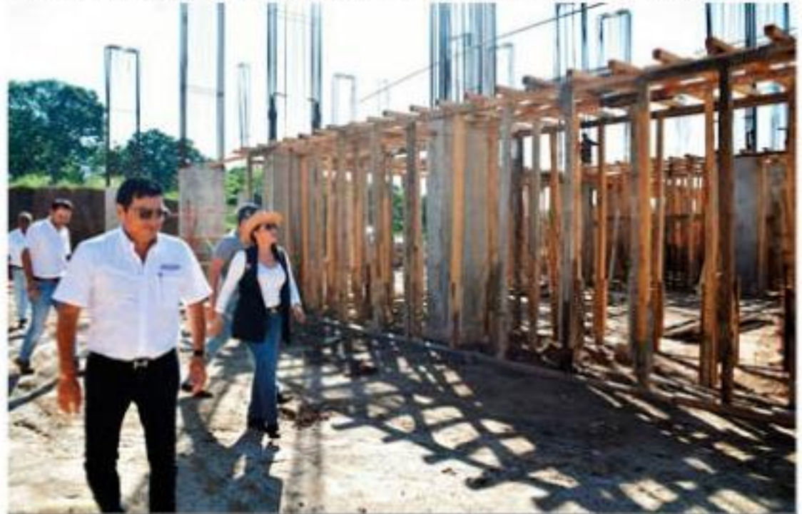
Durante el primer semestre de este año se prevé estén concluidos 2 edificios de la Universidad Politécnica de LC, según lo afirmó la Directora General del IFEEM, María Guadalupe Díaz Chagolla, durante un recorrido que realizó por la obra.
