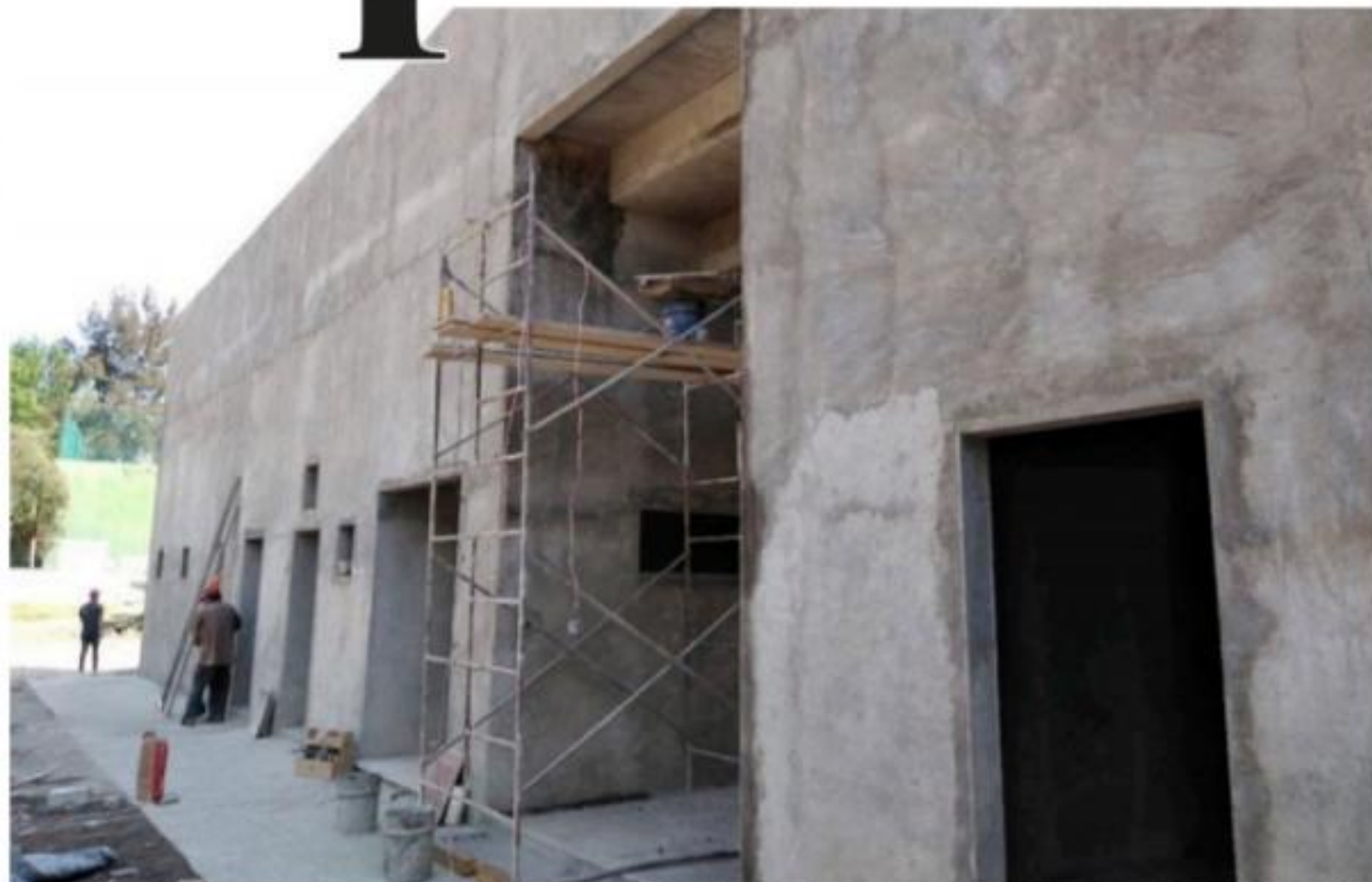
URUAPAN, MICH.- Esta misma semana podrían quedar concluidos los trabajos de remodelación del estadio de fútbol de la unidad deportiva "Hnos. López Rayón", indicó el secretario de Obras Públicas y Servicios Municipales, Jesús Mariano Torres Santoyo.
