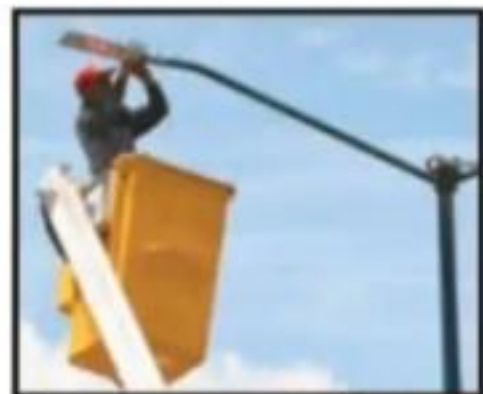
En algunas zonas de Morelia ya se han sustituido las luminarias.
