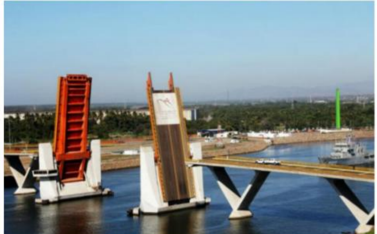
CD. LÁZARO CÁRDENAS, MICH.- En este mes de junio el puente Albatros cumple 8 años de operaciones; es la obra más reciente de los puentes en al delta del río Balsas, el paso conecta la isla del Cayacal con los muelles de metales y minerales y la isla de Enmedio.
