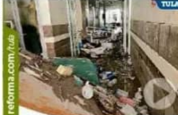
El hospital del IMSS en Tula quedó destruido. Autoridades del instituto iniciarán hoy su rehabilitación.
