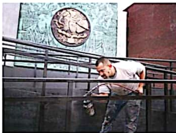
Trabajadores empujaron la Cámara de Diputados y las barequetas, asfalto y árboles de las calles adyacentes, con el fin de que todo este listo para que el 1 de diciembre arriben Andrés Manuel López Obrador y un 900 invitados a la toma de posesión como Presidente de México. NACIÓN A4
