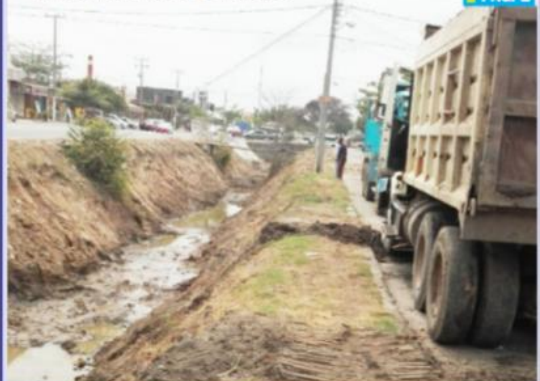
CD. LÁZARO CÁRDENAS, MICH.- Las labores de limpieza y desazolve en los canales pluviales del municipio superan, en algunos casos, el 50 por ciento.
