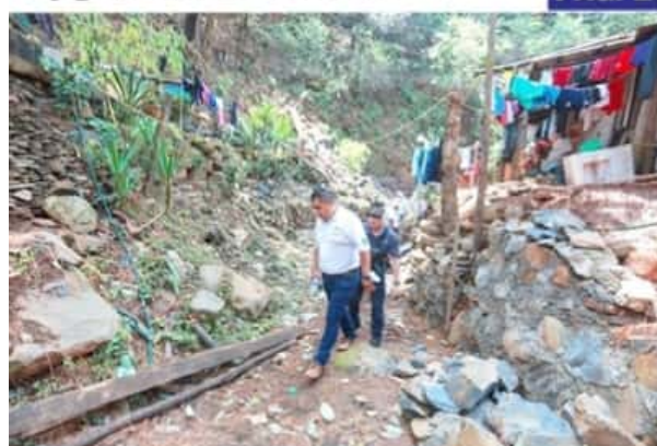
URUAPAN, MICH.- Una inspección realizada a la colonia La Bolita, dejó ver el gran riesgo que existe de deslaves e inundaciones, debido sobre todo a que la basura tapa las salidas del agua y a que sigue la invasión de espacios.
