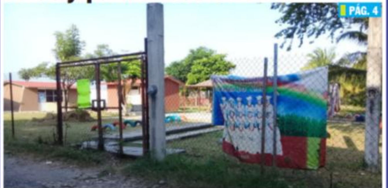
CD. LÁZARO CÁRDENAS, MICH.- La presidenta municipal María Itzé Camacho Zapala anunció que en los próximos días se iniciará con la construcción de un aula en un Jardín de Niños, así como la pavimentación de 270 metros lineales de la colonia Aeropuerto en la tenencia de Las Guacamayas.
