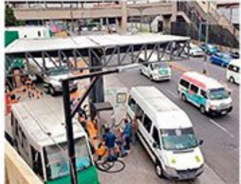
En la gasera se surte de combustible el transporte público, pero también cilindros caseros.
