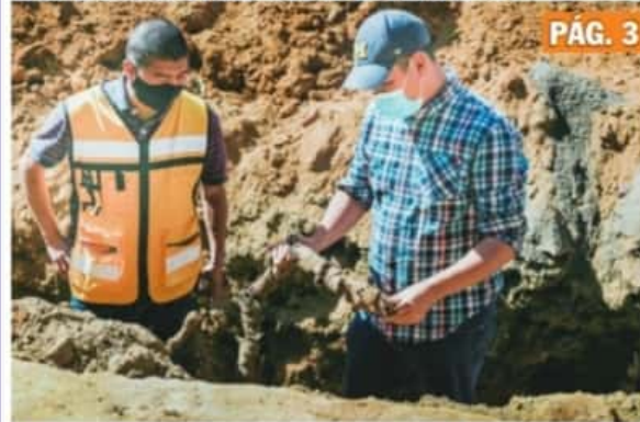
URUAPAN, MICH.- El presidente municipal, Miguel Ángel Paredes Melgoza, supervisa personalmente los avances en los trabajos de modernización del Paseo Gral. Lázaro Cárdenas.
