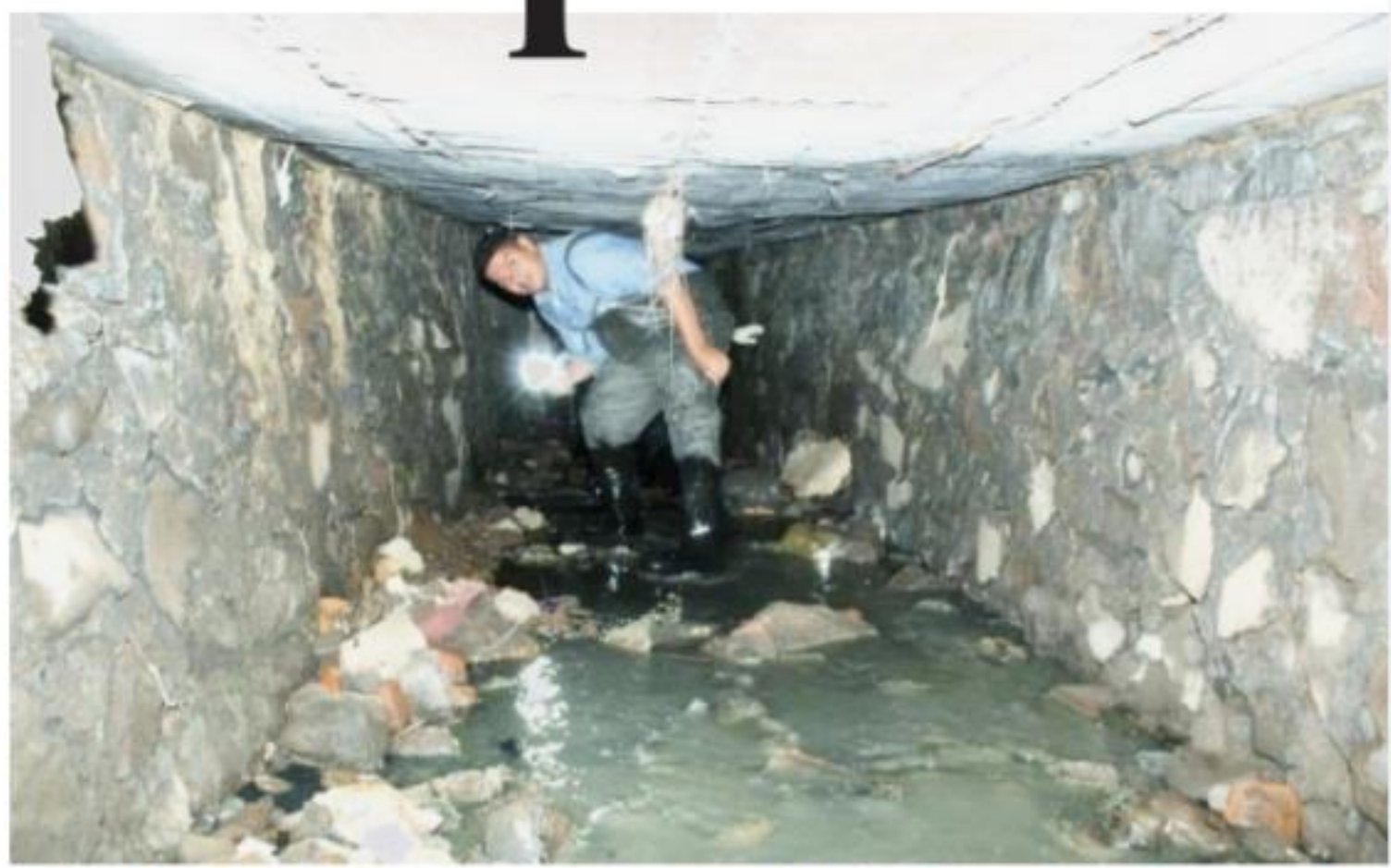
URUAPAN, MICH.- Para evitar contingencias en la temporada de lluvias, la Capasu lleva a cabo el desazolve de bóvedas y drenes del sistema sanitario de la ciudad.
