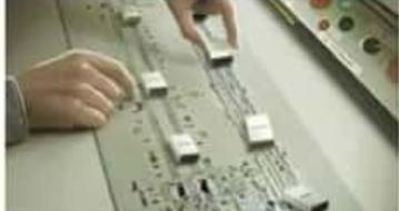
Desde el Puesto Central de Control del Metro, los controladores acomodan las fichas de dominó para simular el desplazamiento y localización de trenes, conforme la indicación del conductor. Así calculan las distancias entre convoyes para evitar accidentes.
