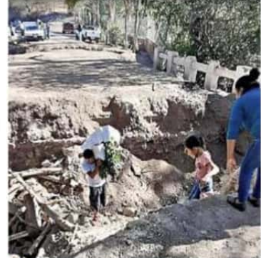
Las carreteras que comunican a Aguillilla están bloqueadas o con zanjas hechas por el crimen para frenar el ingreso de rivales a la zona.
