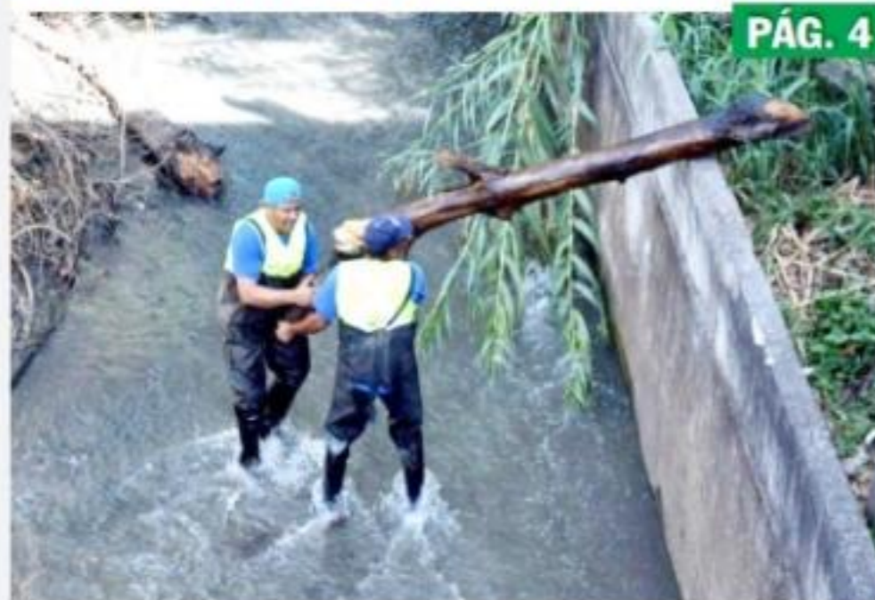
URUAPAN, MICH.- Trabajadores de la Capasu, iniciaron la rehabilitación en el colector El T'arhechu.
