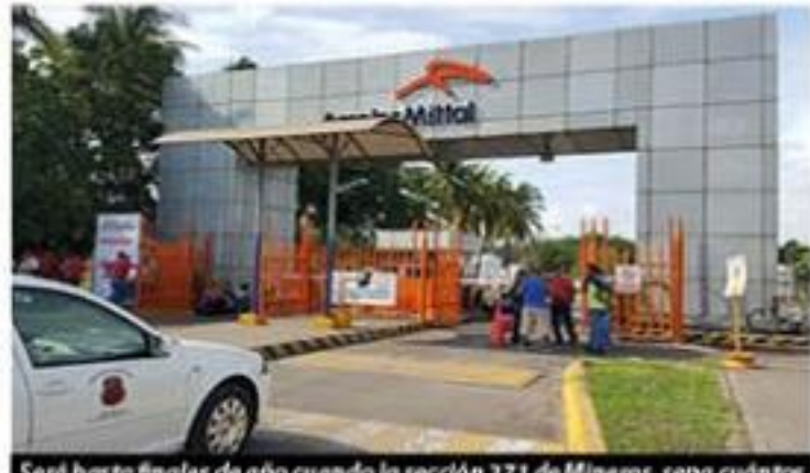
Será hasta finales de año cuando la sección 271 de Mineros, sepa cuántos obreros afiliados a ese gremio, requerirá la planta Laminadora que actualmente construye ArcelorMittal.
