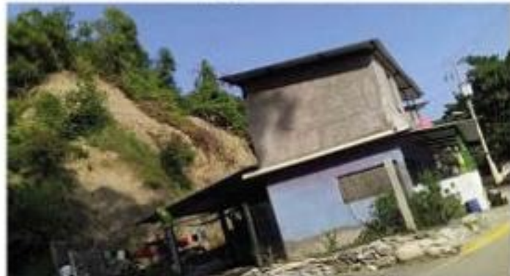
El derrumbe de un nuevo cerro en la colonia Presa La Villita de la tenencia de Guacamayas, mantiene en estado de alerta a PCM.
