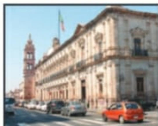
Edificio que alberga las "oficinas centrales" del IMSS a nivel nacional está semivacío.
