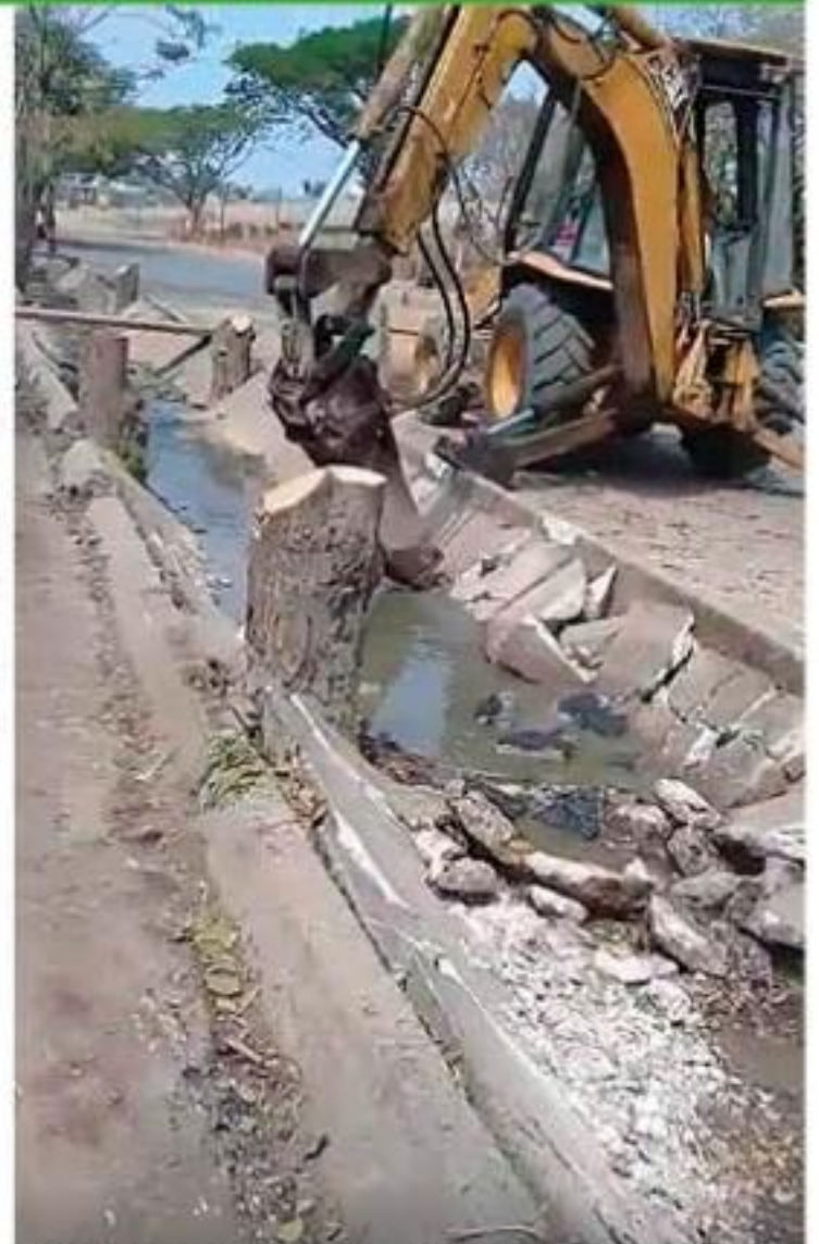
El CAPALAC ha iniciado la reparación de tubería dañada del colector central que pasa por la avenida Narciso Bassols, para evitar que las aguas negras sigan corriendo a cielo abierto en ese sitio, y en el canal de la Noyola.
