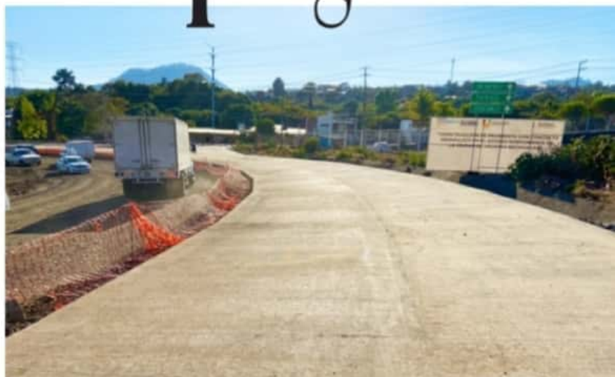
URUAPAN, MICH.- El secretario de Obras Públicas y Movilidad, Mariano Torres Santoyo, informó que da el avance en la obra del Acceso Norponiente a la ciudad, podría finalizar un mes antes de lo programado inicialmente.
