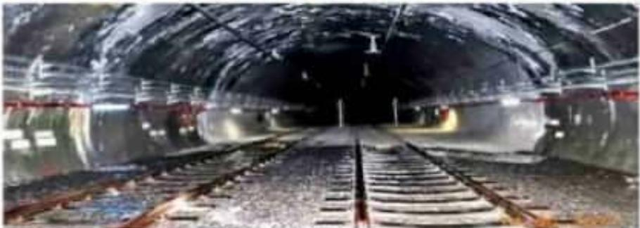
Entre los cadenamientos 29+260 al 29+280 se presentan graves problemas de filtraciones, escurrimientos y goteo de agua en la bóveda y paredes del túnel.
