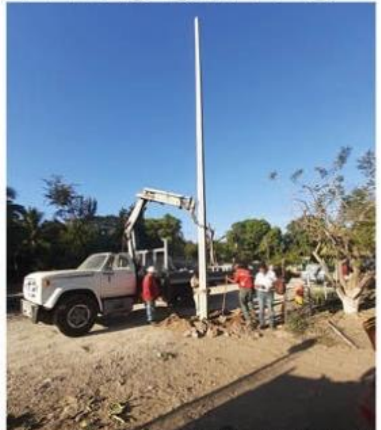
Personal del área de Alumbrado Público del municipio, desde el pasado martes inició la colocación de postes para que en un mes más que terminen con esa labor, la CFE pueda electrificar la colonia Plutarco Elías Calles de la tenencia de Guacamayas, en beneficio de casi 500 habitantes.
