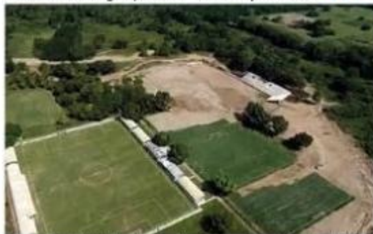
Panorámica del sitio donde actualmente se construye el estadio de fútbol del Club Cocodrilos de esta ciudad.
